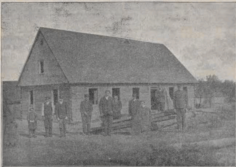
Żarnówka. Budowa domu parafialnego. (Par. Grębków.)
