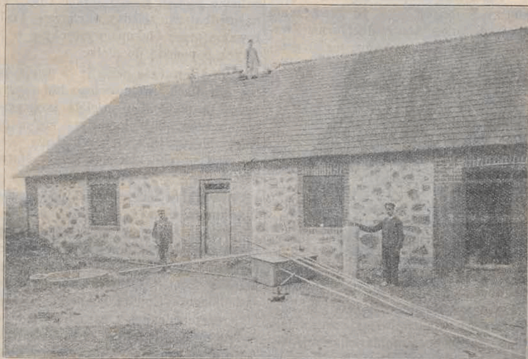
Wiśniew. Budowa kąpieli ludowych.
