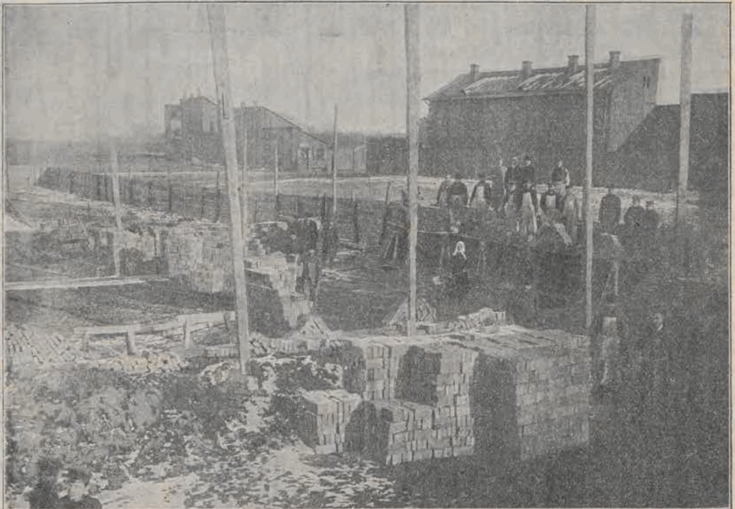
Budowa kaplicy na Pradze.
