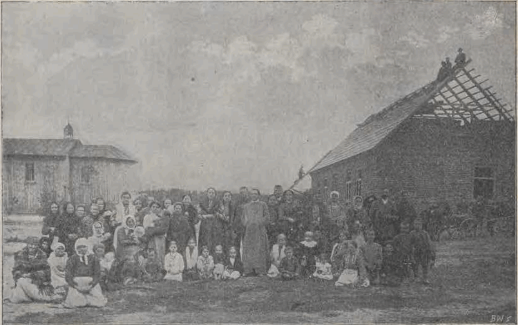
Jeruzal. Budowa domu parafialnego.
