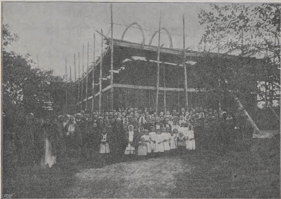
Budowa kościoła w Łowiczu.
